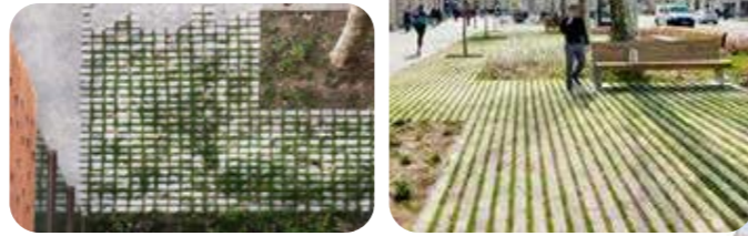
CAMBIO PAVIMENTO PERMEABLE
