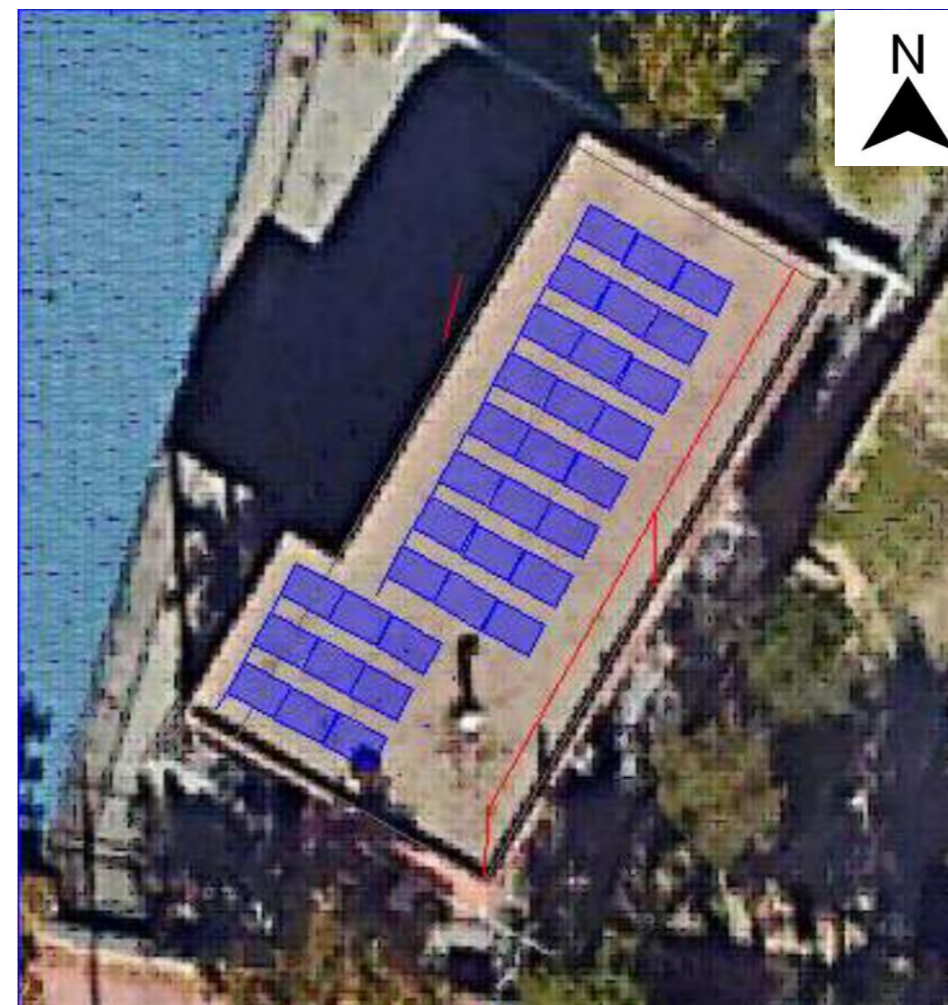
Edificio 2: 33 paneles 13,69 kWp
