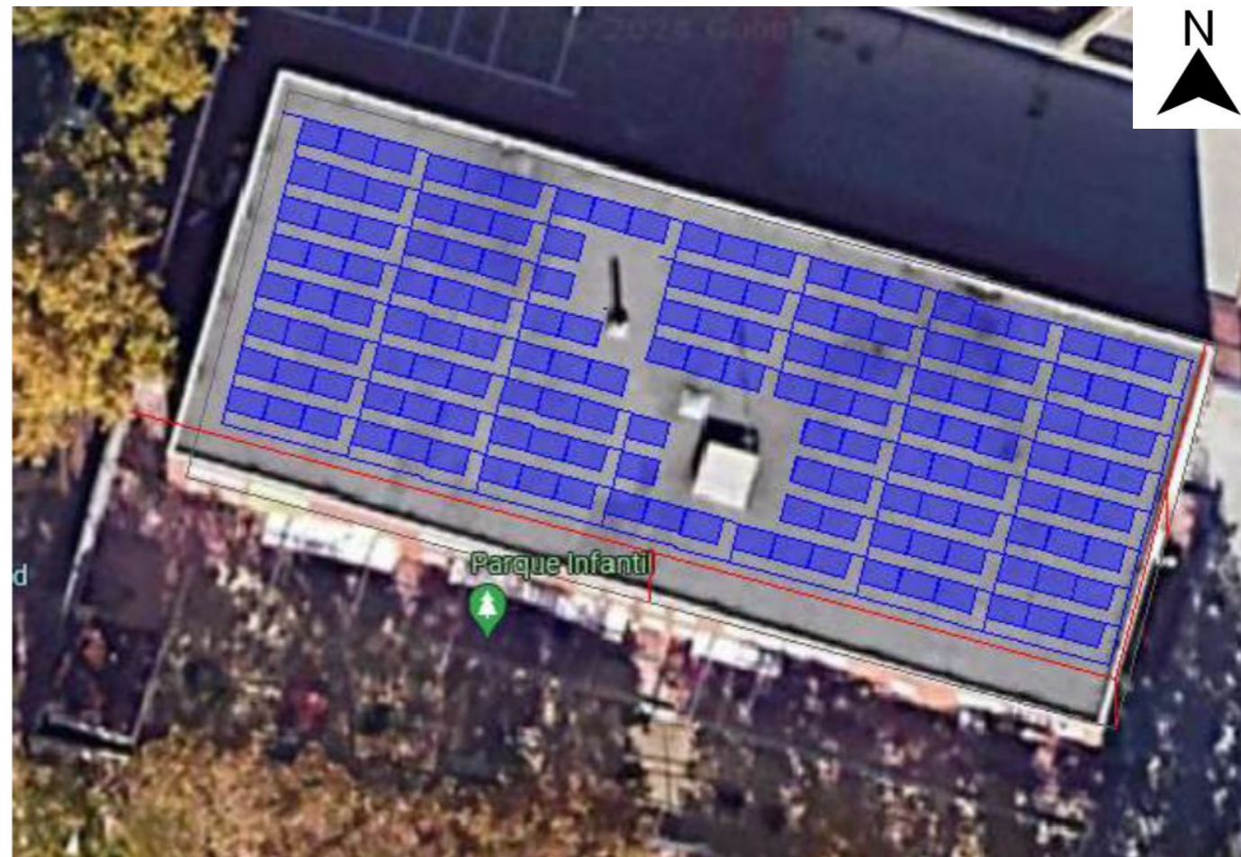
Edificio 1: 156 paneles 62,5 kWp
